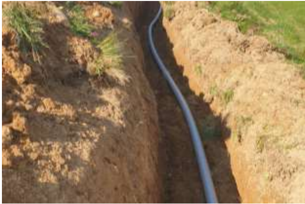
Sanierung der Quellwasserleitung Oberer Chenner Landw. Verein
